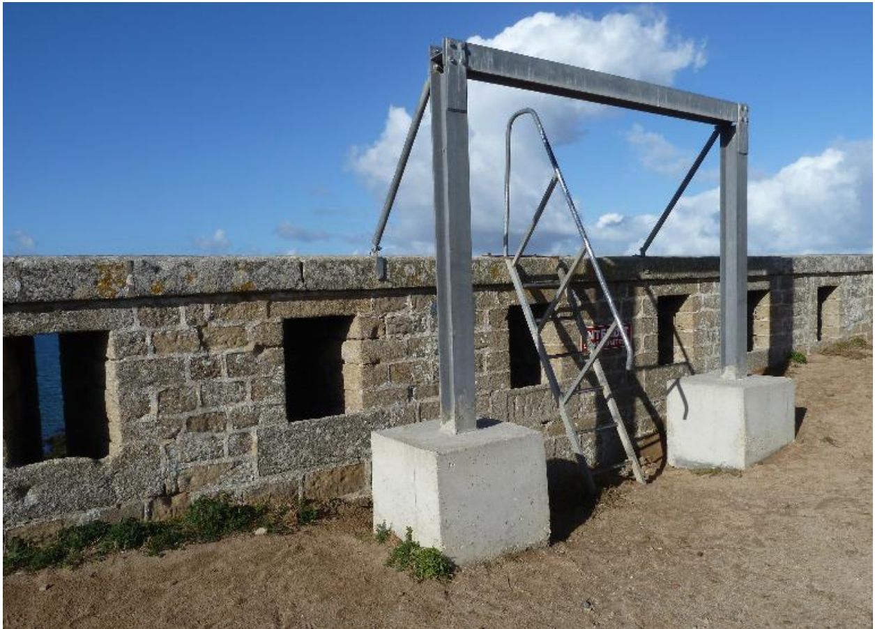
Saint-Pierre-Quiberon, fort de Penthievre, enceinte, parapet crénelé du front sud-ouest.
