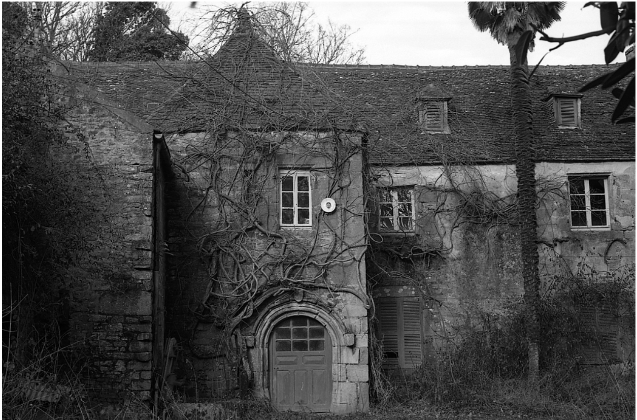
Manoir, état en 1979, élévation est, vue générale
