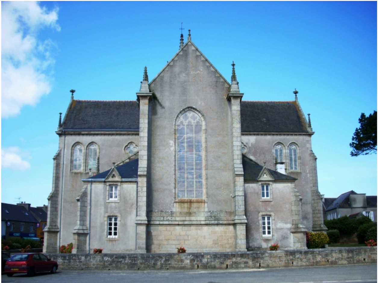
Kerlouan, église paroissiale : élévation est
