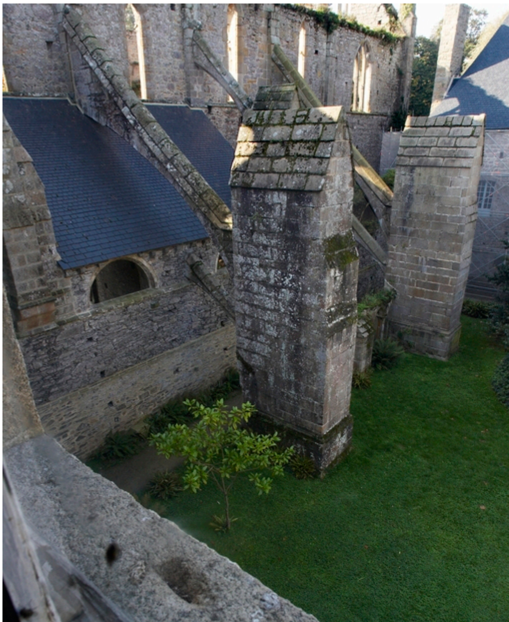
Contreforts et arcs boutants au nord de l'église abbatiale
