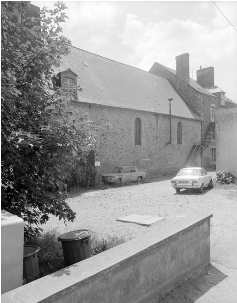
Chapelle des Recollets, 88 rue de la Forêt, vue générale.
