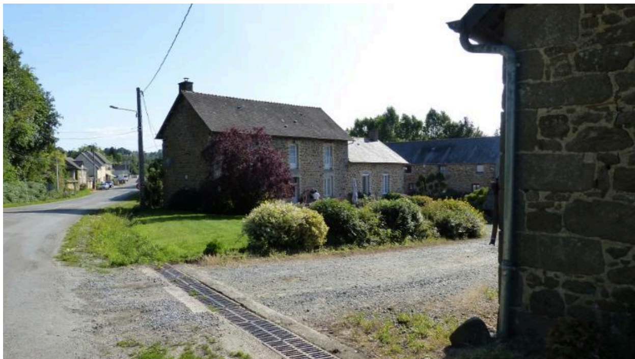
Vue générale nord
