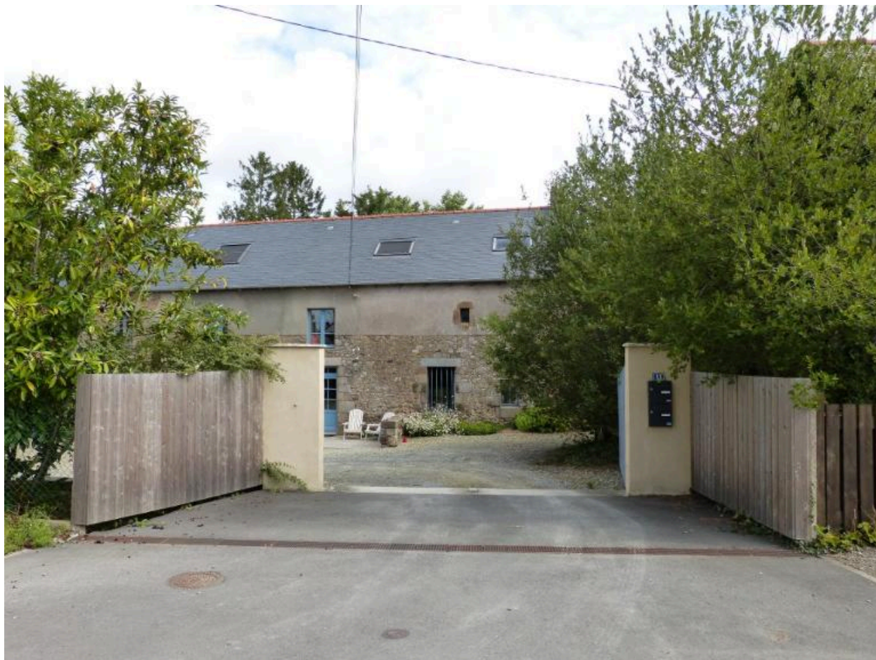
Vue générale sud
