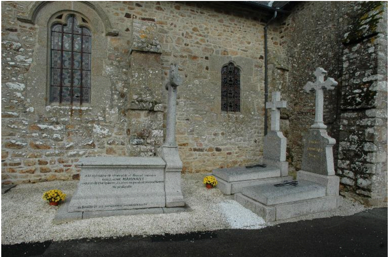
Façade sud de l'église et tombes du cimetière
