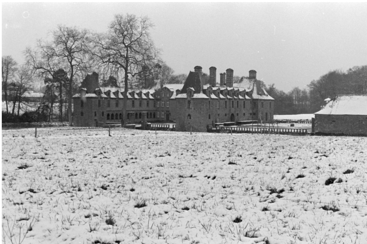
Vue générale du Rocher-Portail
