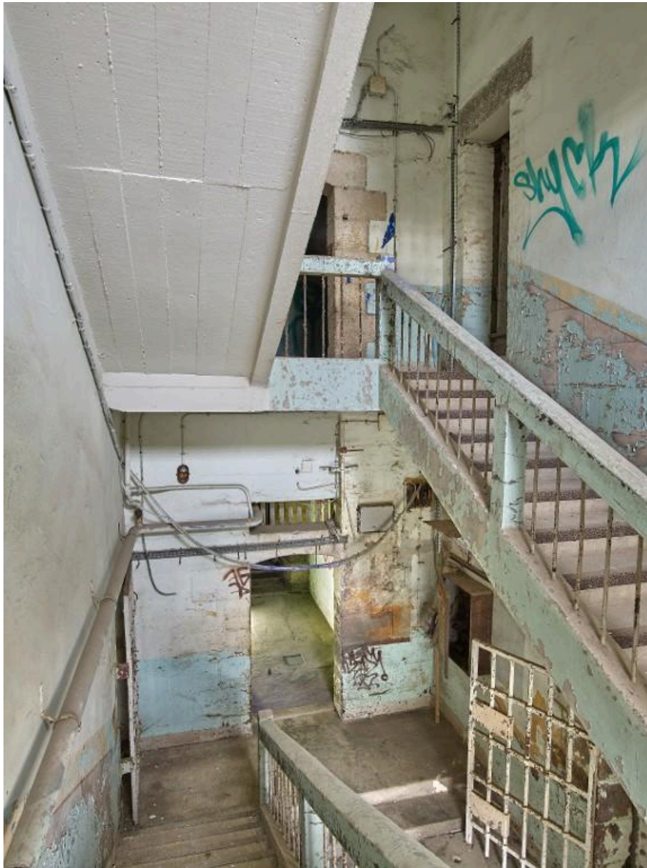
Vue de la cage d'escalier depuis le palier situé entre le rez-de-chaussée et le premier étage. L'escalier est en béton armé
