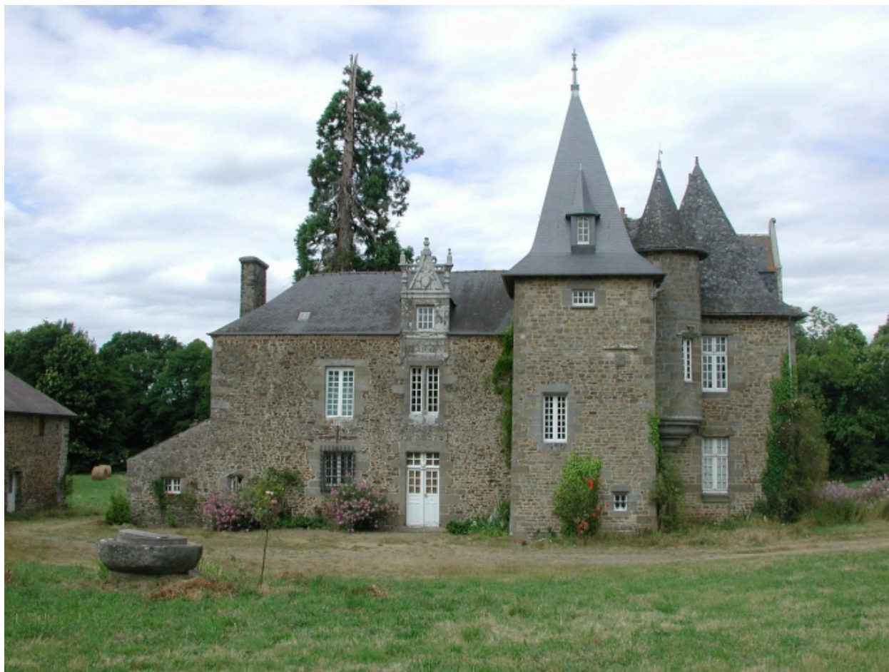
Vue générale sud
