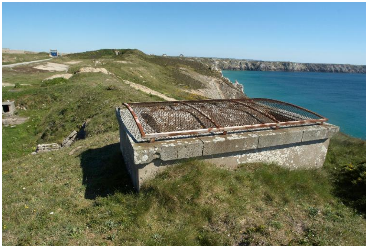
Camaret, pointe du Toulinguet : batterie de côte, traverse-abri
