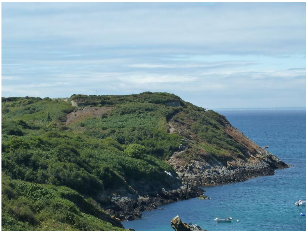
Groix, batterie du Bas-Grognon, vue générale depuis l'est.
