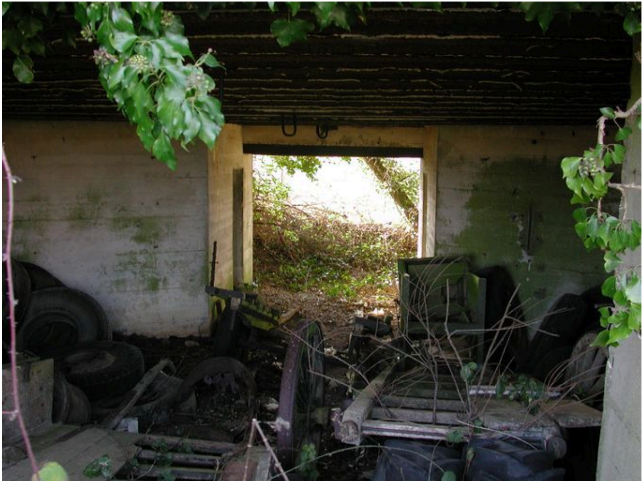
Vue intérieure de l'un des quatre bunkers - casemates de type 669 (état en 2002)
