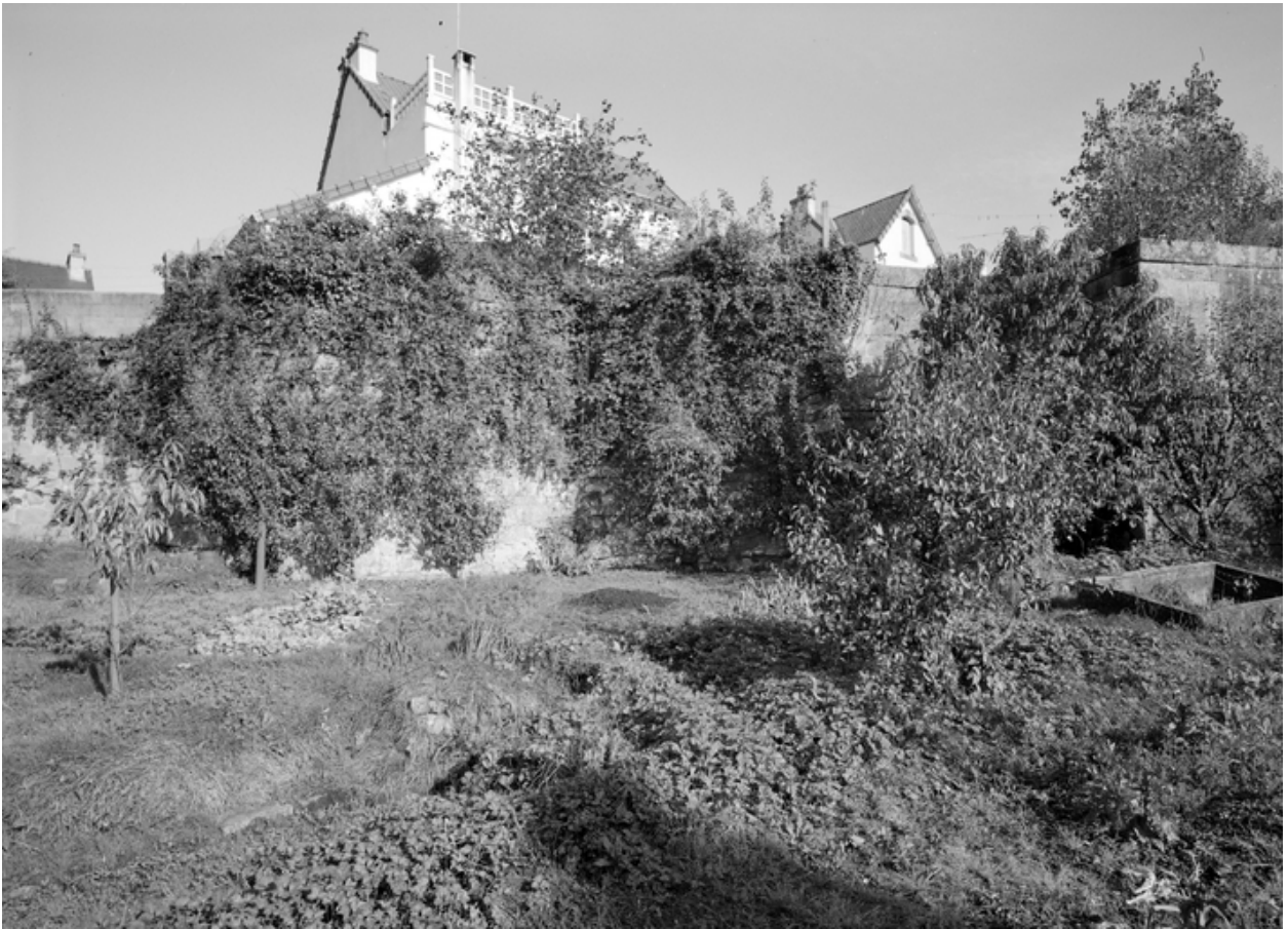
Vue générale des murailles prise du jardin du 22 rue du château
