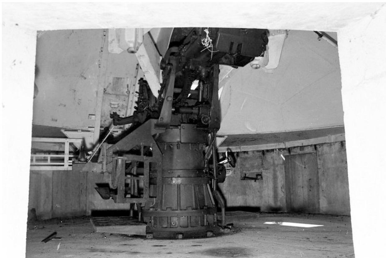
Vue de l'un des quatre canons antiaériens de 10,5 cm sous blindage (état en 1969)
