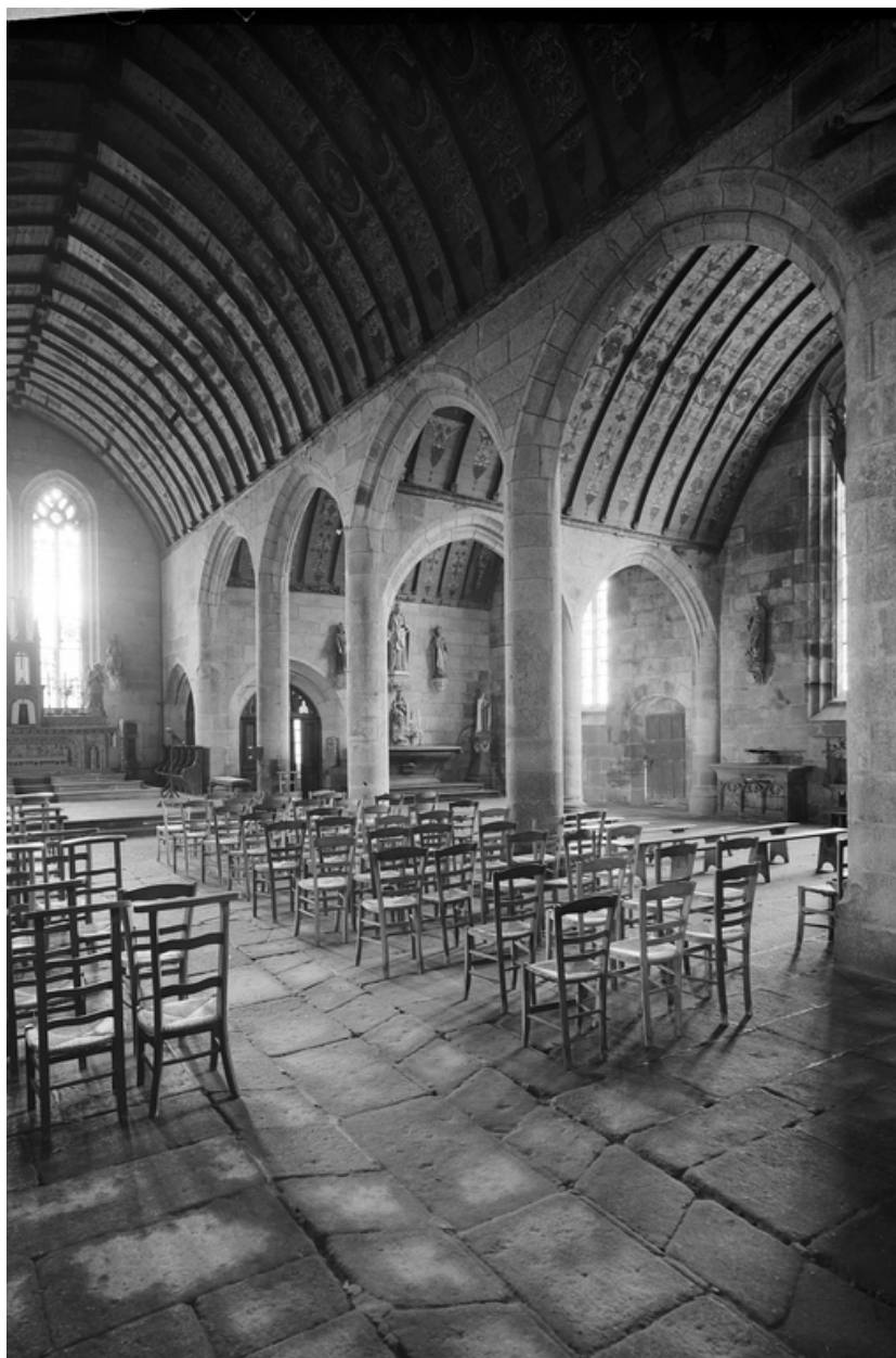
Croisillons sud : vue axiale nord ouest / sud ouest
