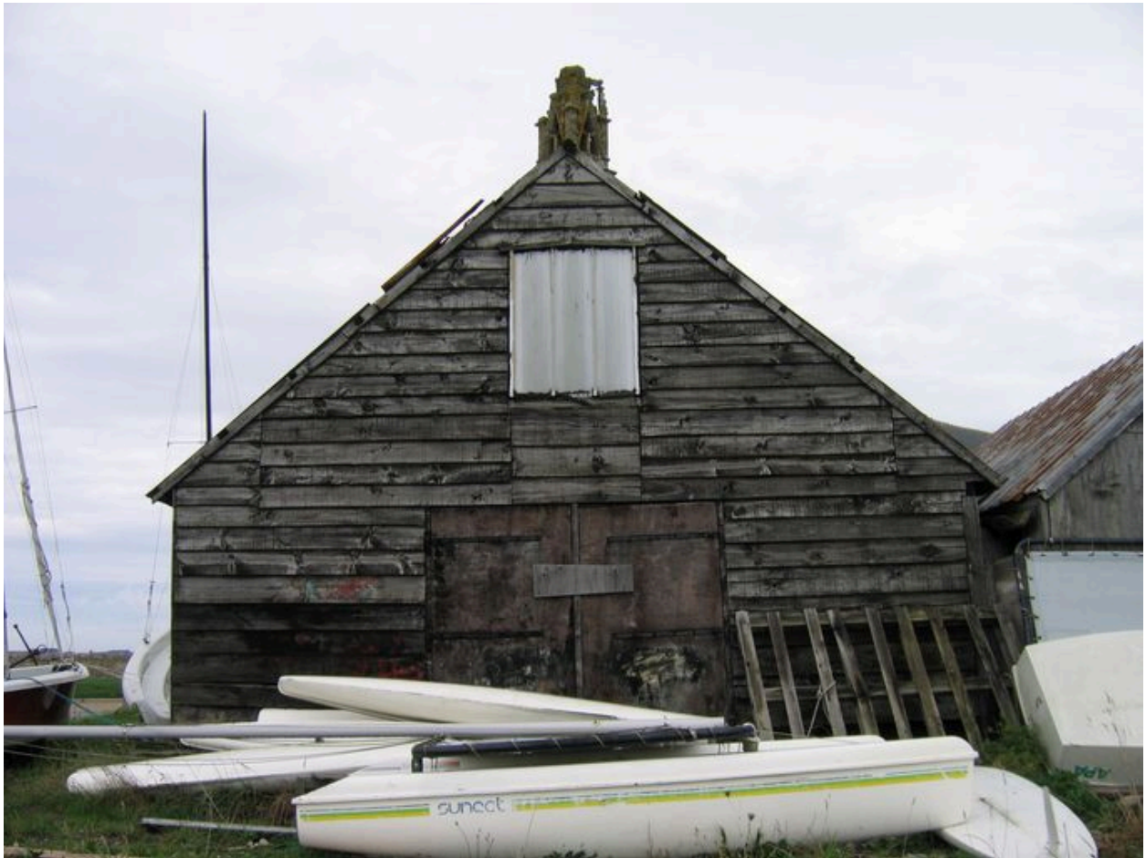
Vue générale de le Cabane Le Dé
