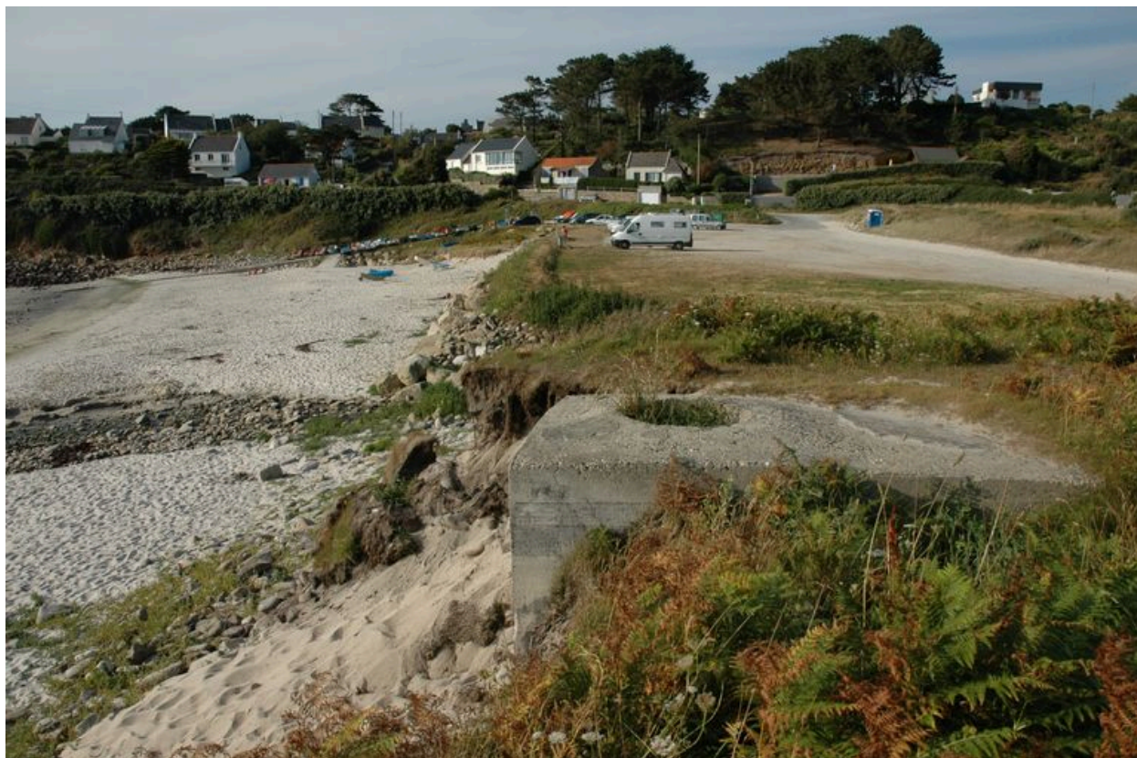
Vue de l'ensemble fortifié d'Illien (Stützpunkt Kerlouchouan) (Re 38, 39, Re 99-103, Re 124) : poste d'observation et de mitrailleuse dit Tobrouk
