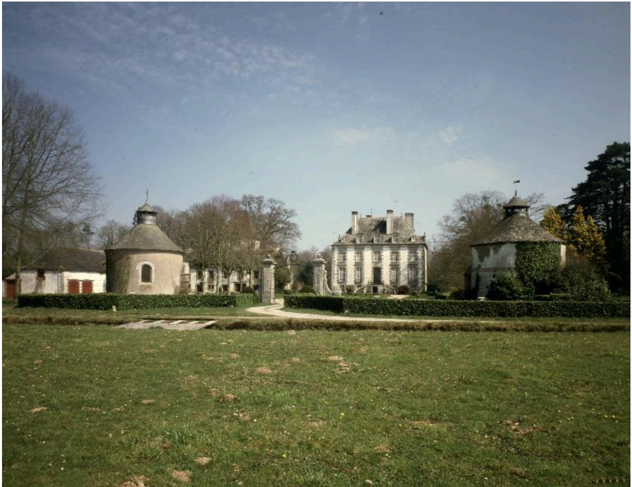
Château : vue de situation est (état en 1984)
