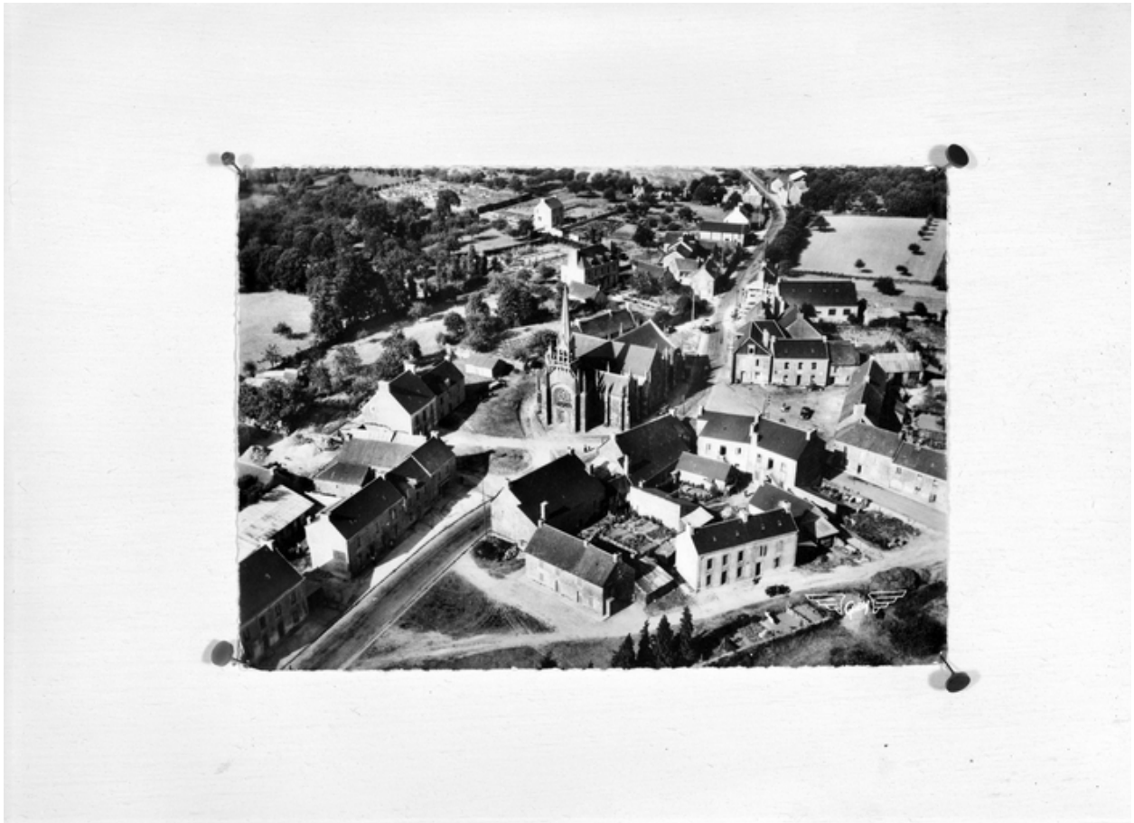
Vue aérienne sud-ouest.
