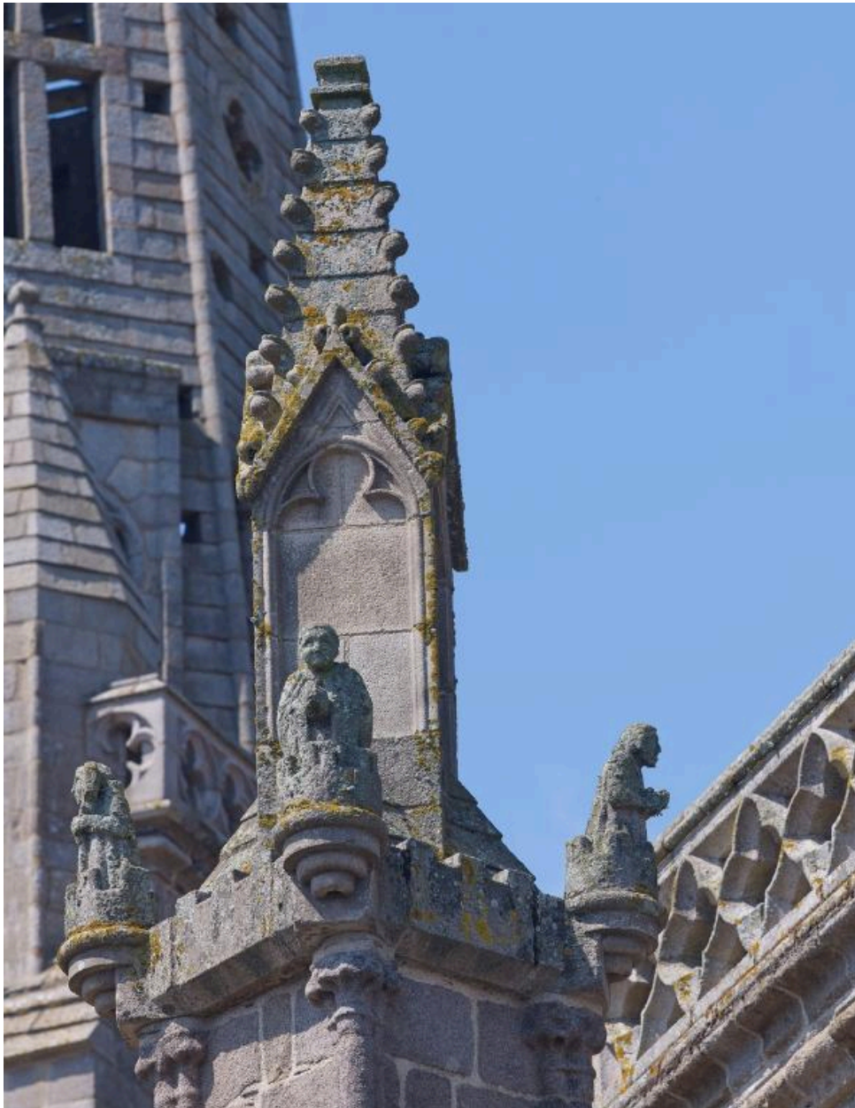
Détail de l'un des pinacles des contreforts du chevet
