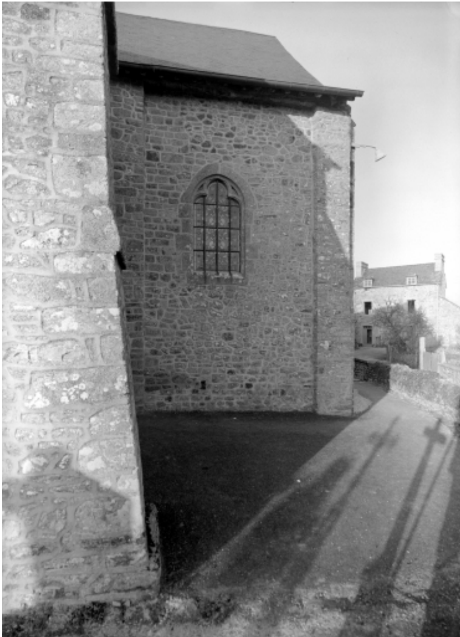
Elévation sud, partie est : vue générale
