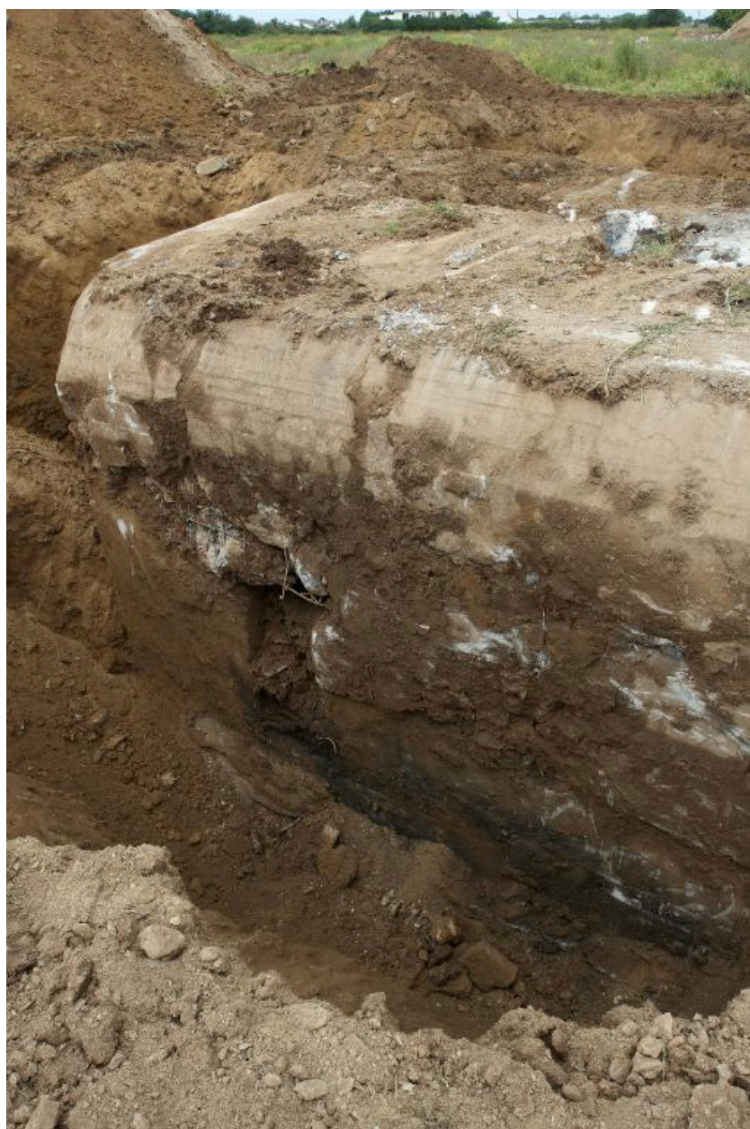
Déconstruction d'un bunker de type 502
