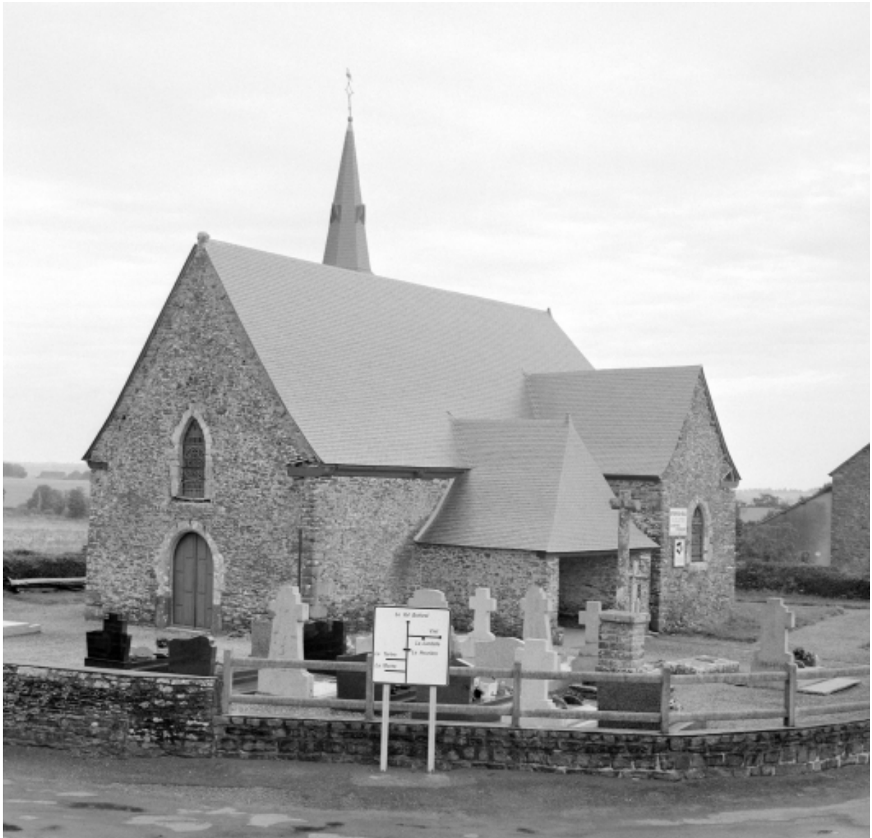
Elévation Sud-Ouest : vue générale
