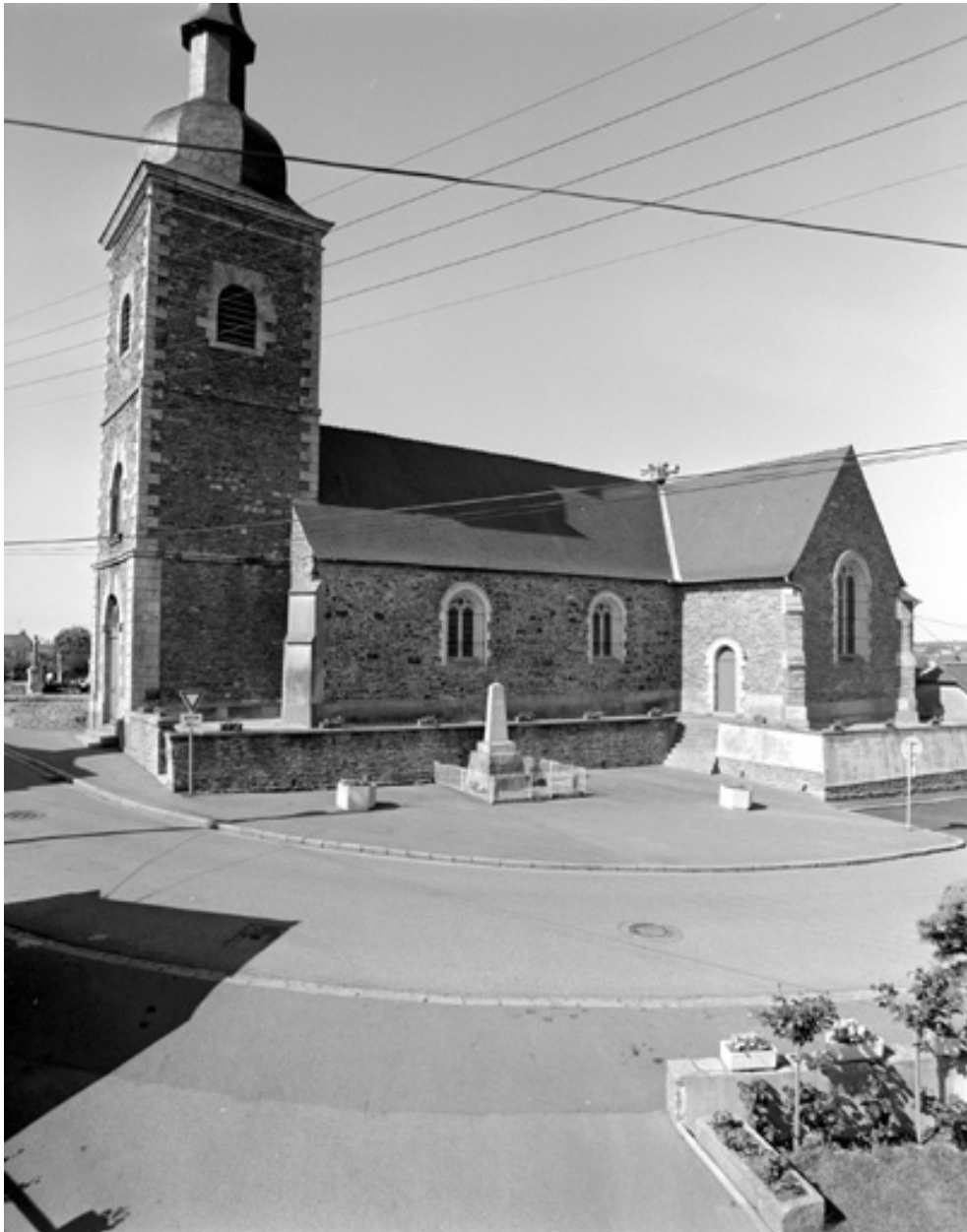
Elévation Sud : vue générale
