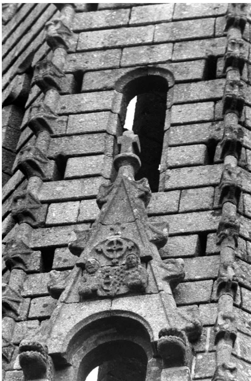
Flèche, face sud : gâble de la partie inférieure
