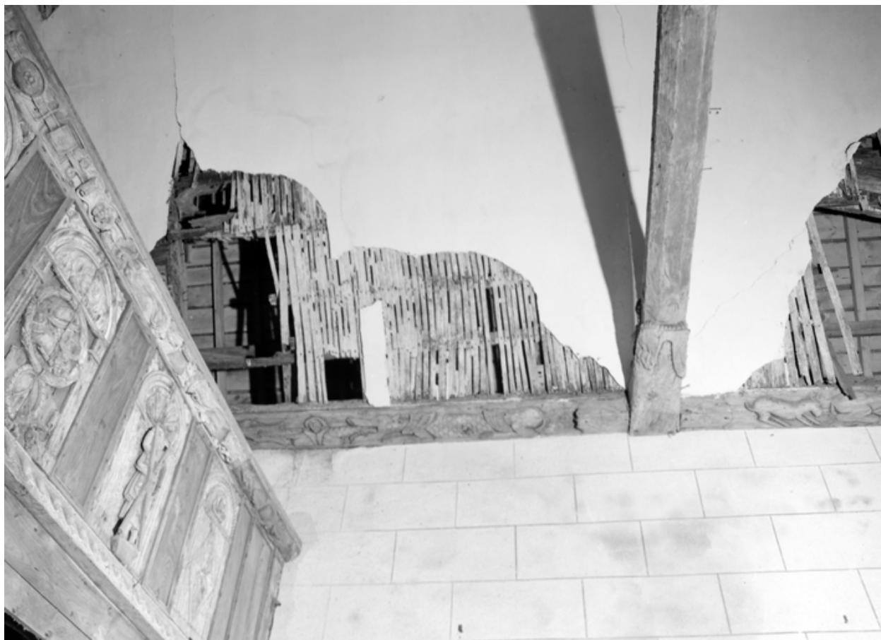
Sablères, mur nord.
