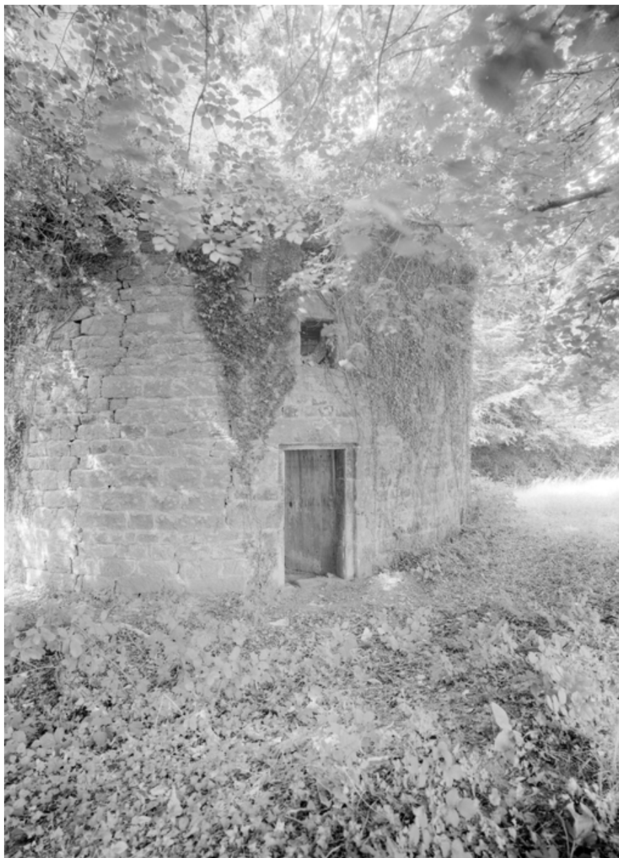
Colombier, façade est, état en 1967
