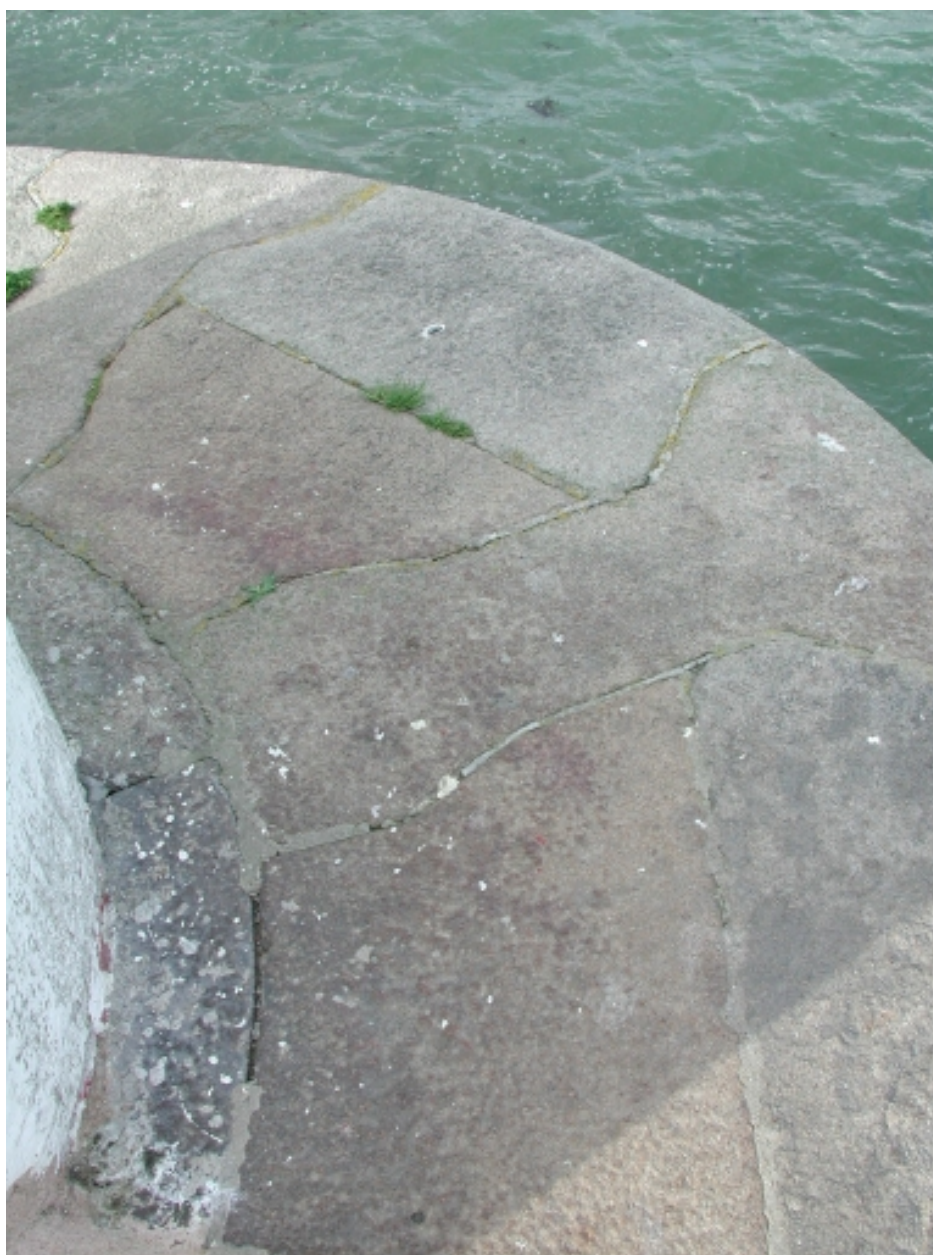
Vue de détail de l'agencement des pierres du musoir de la jetée du quai de l'Eperon
