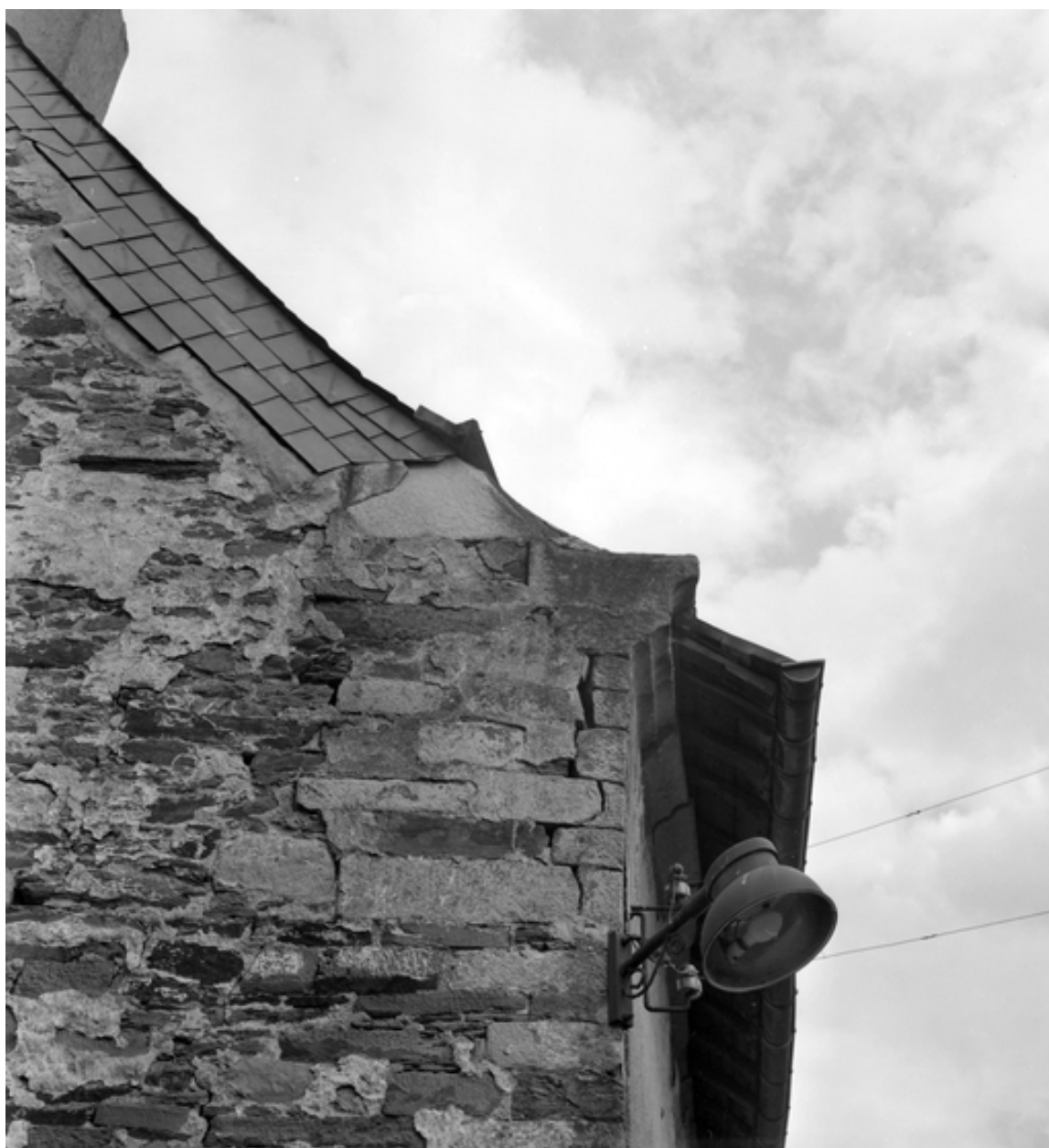
Détail de la corniche de la façade sud-ouest.
