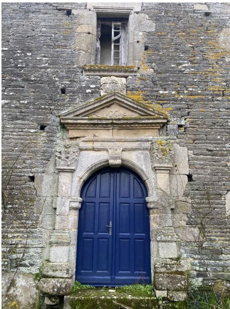
Porte, élévation ouest, détail
