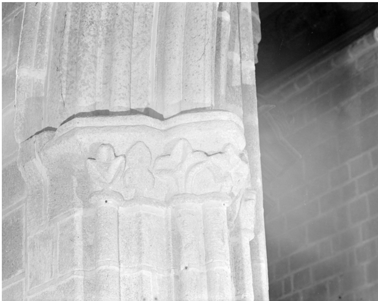
Nef, 2° pile sud, chapiteau
