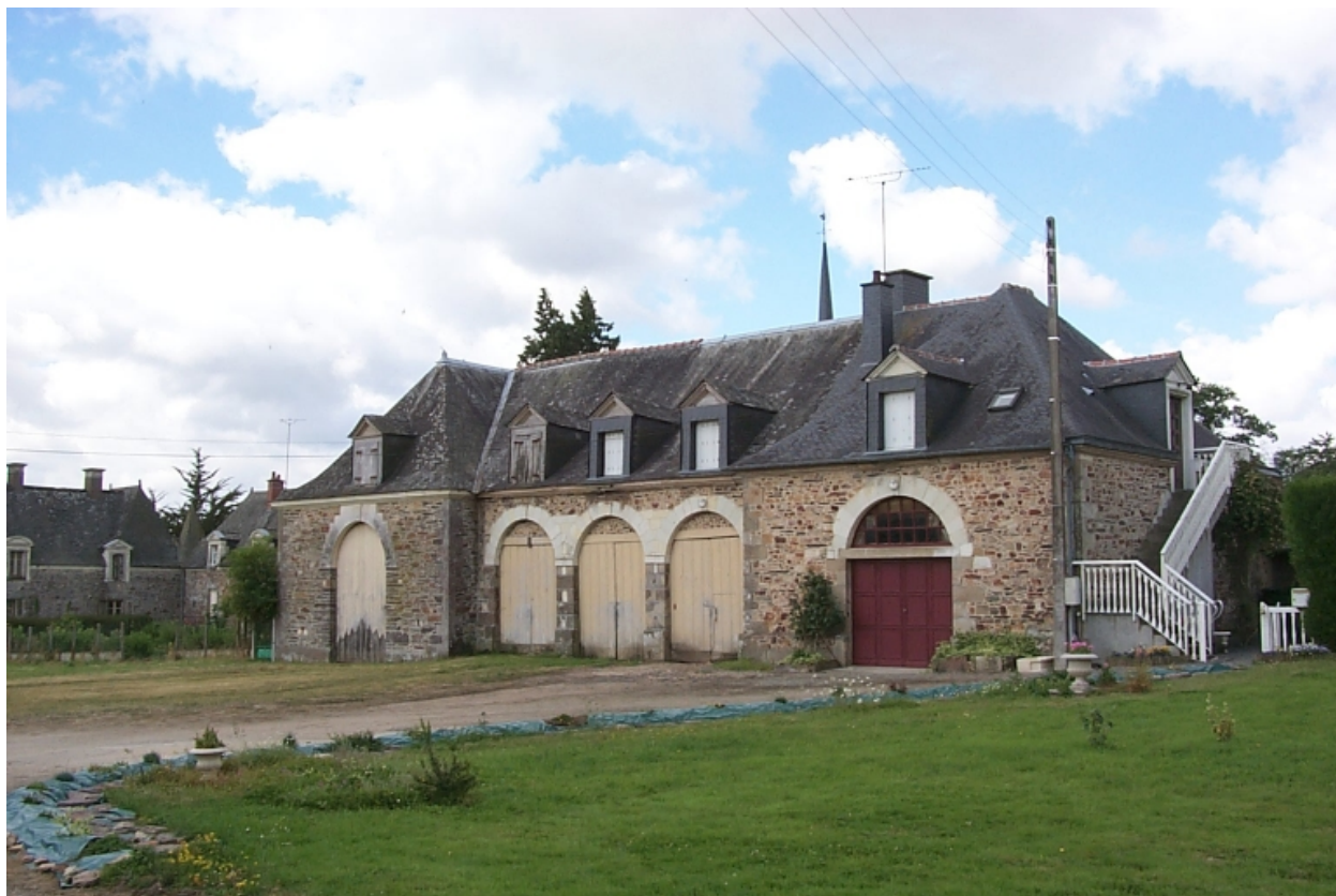
La remise à carrosses : vue générale nord-est
