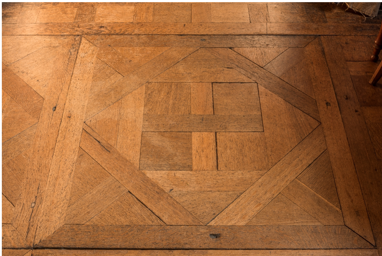
Le parquet d'assemblage, vue de détail en plongée
