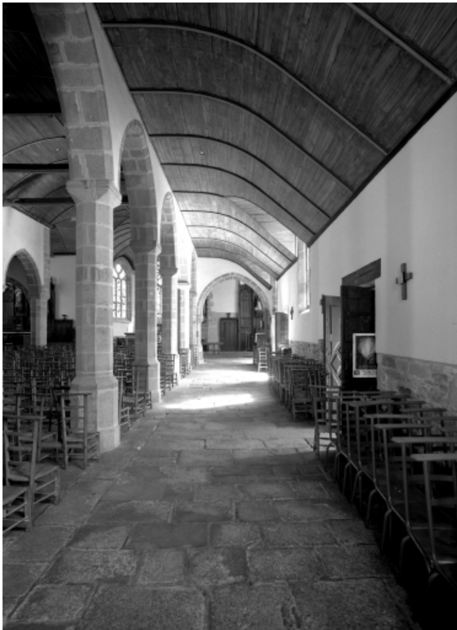
Plomodiern, église paroissiale Saint-Mahouarn : bas-côté sud, vers l'est, état en 1970
