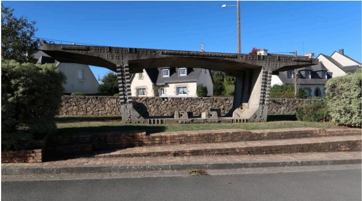
Prototype de voussoir du viaduc du Gouet : "Cette pièce appelée voussoir est le 1er élément réalisé, à titre de prototype, du viaduc du Gouet enjambant le Légué (...) (1980). [Il] a été offert au lycée FREYSSINET afin d'illustrer les formations "TRAVAUX PUBLICS" dispensées ici mais aussi en hommage à Eugène FREYSSINET, ingénieur polytechnicien inventeur du béton précontraint."
