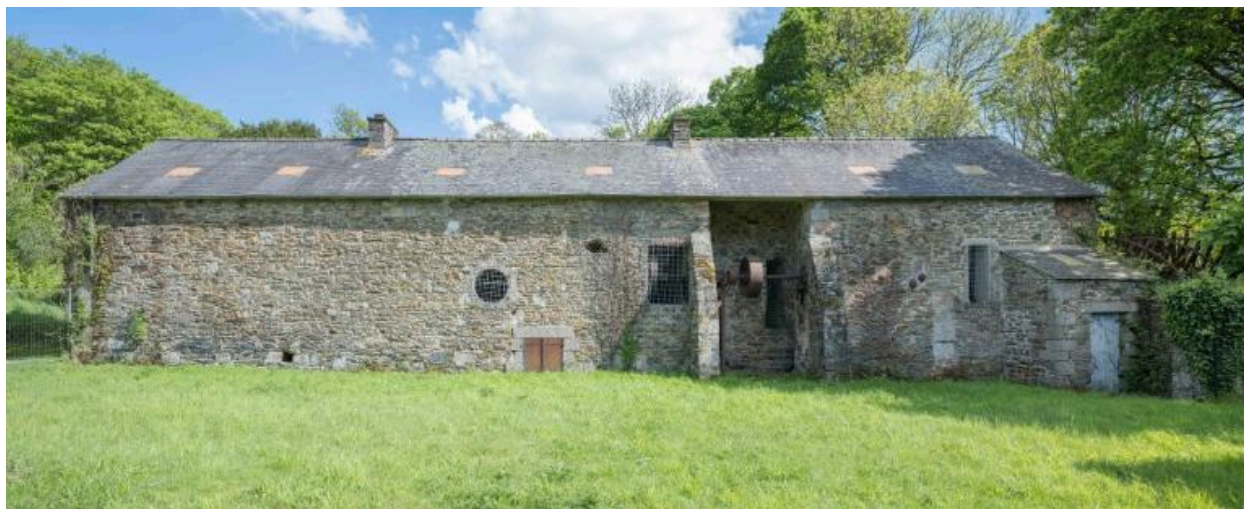
Bâtiment principal. vue générale nord-ouest. Etat en 2025
