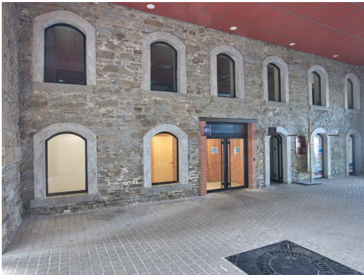
Zone nord du bâtiment : un des accès
