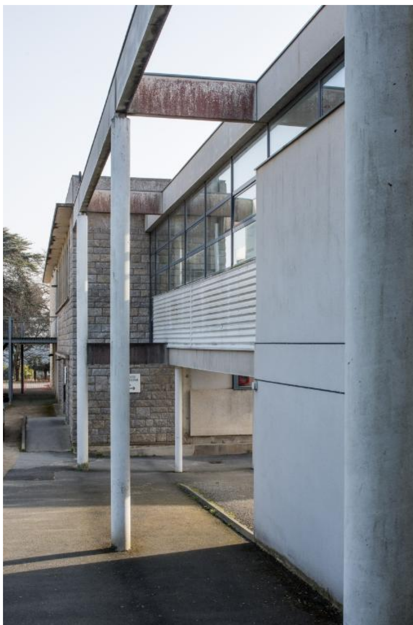
Passerelle entre le restaurant pédagogique et les ateliers.
