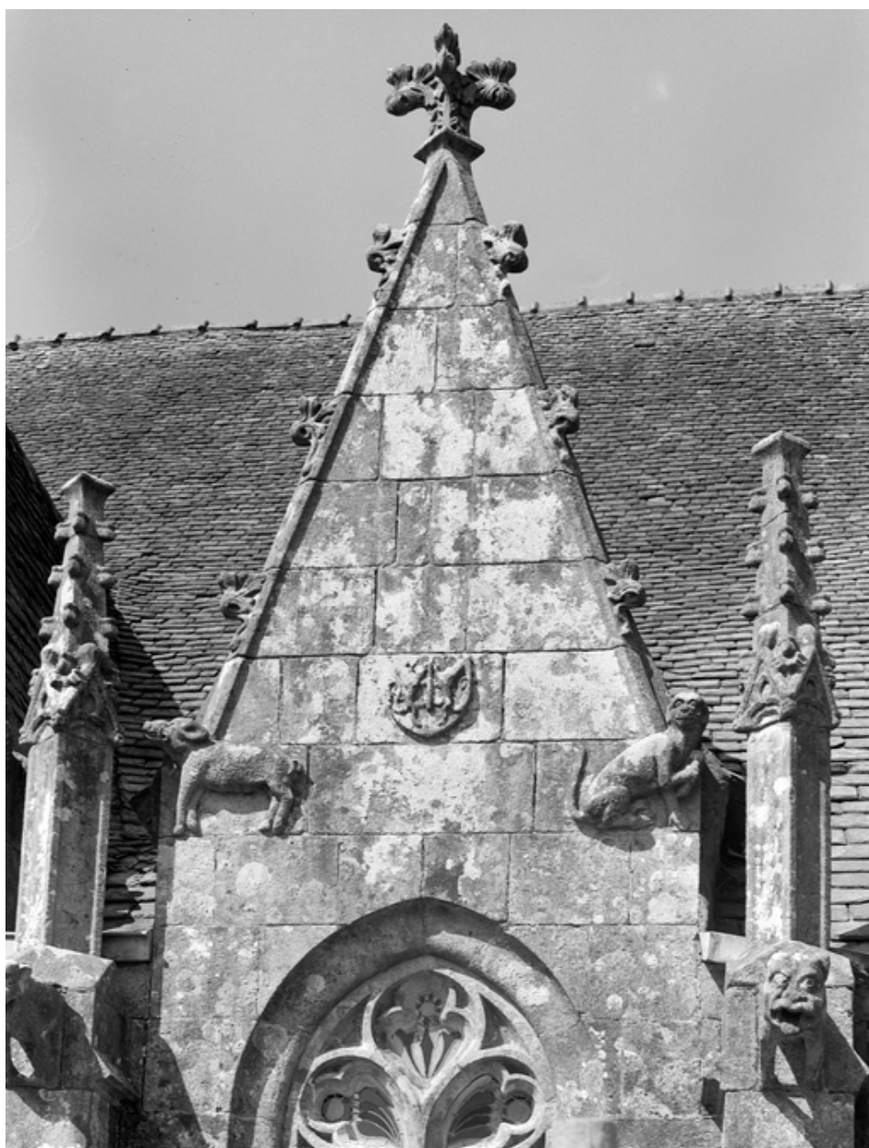
Face sud de la nef : gâble est
