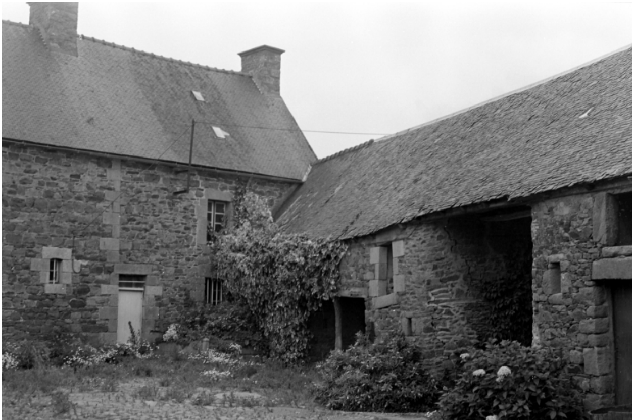
Corps de logis, détail, façade antérieure (cliché S. Laffiché, pré-inventaire, 1973)
