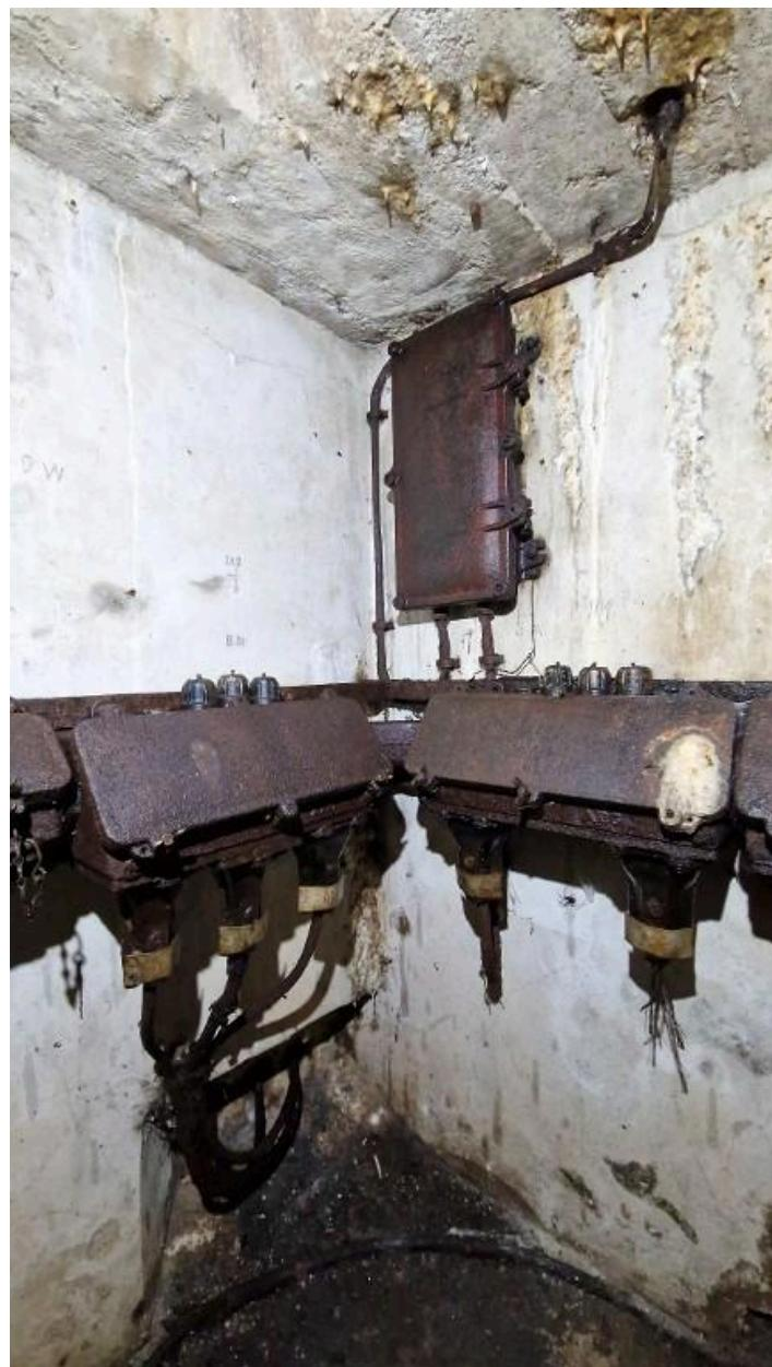
Vue intérieure : ensemble de plusieurs boîtiers de connexion. Sur le mur peint en blanc : des instructions tracées au crayon gris pour connecter les câbles
