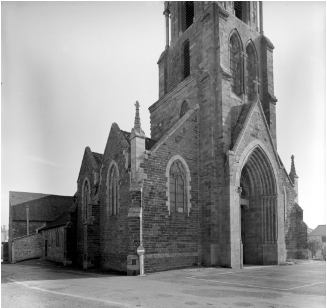
Elévation Nord-Ouest : vue générale
