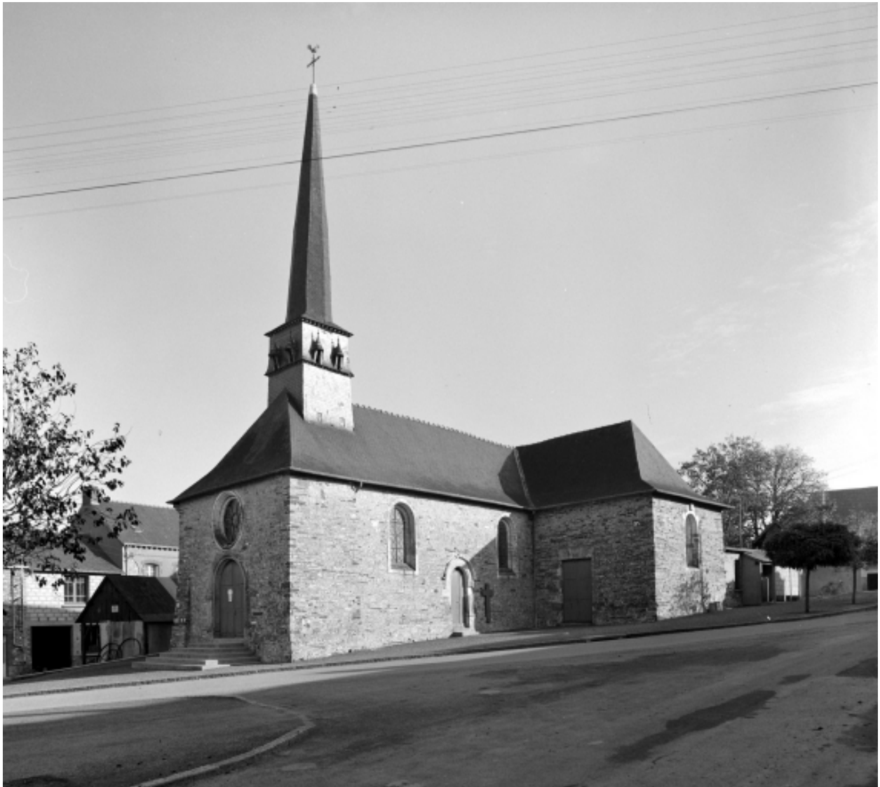
Elévation Sud-Ouest : vue générale
