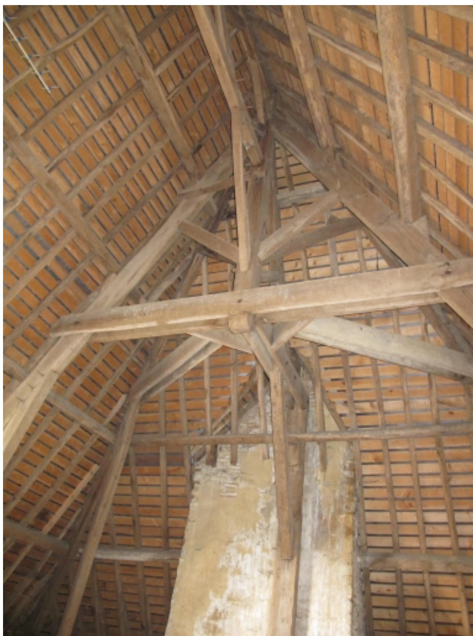
Charpente du pavillon du logis
