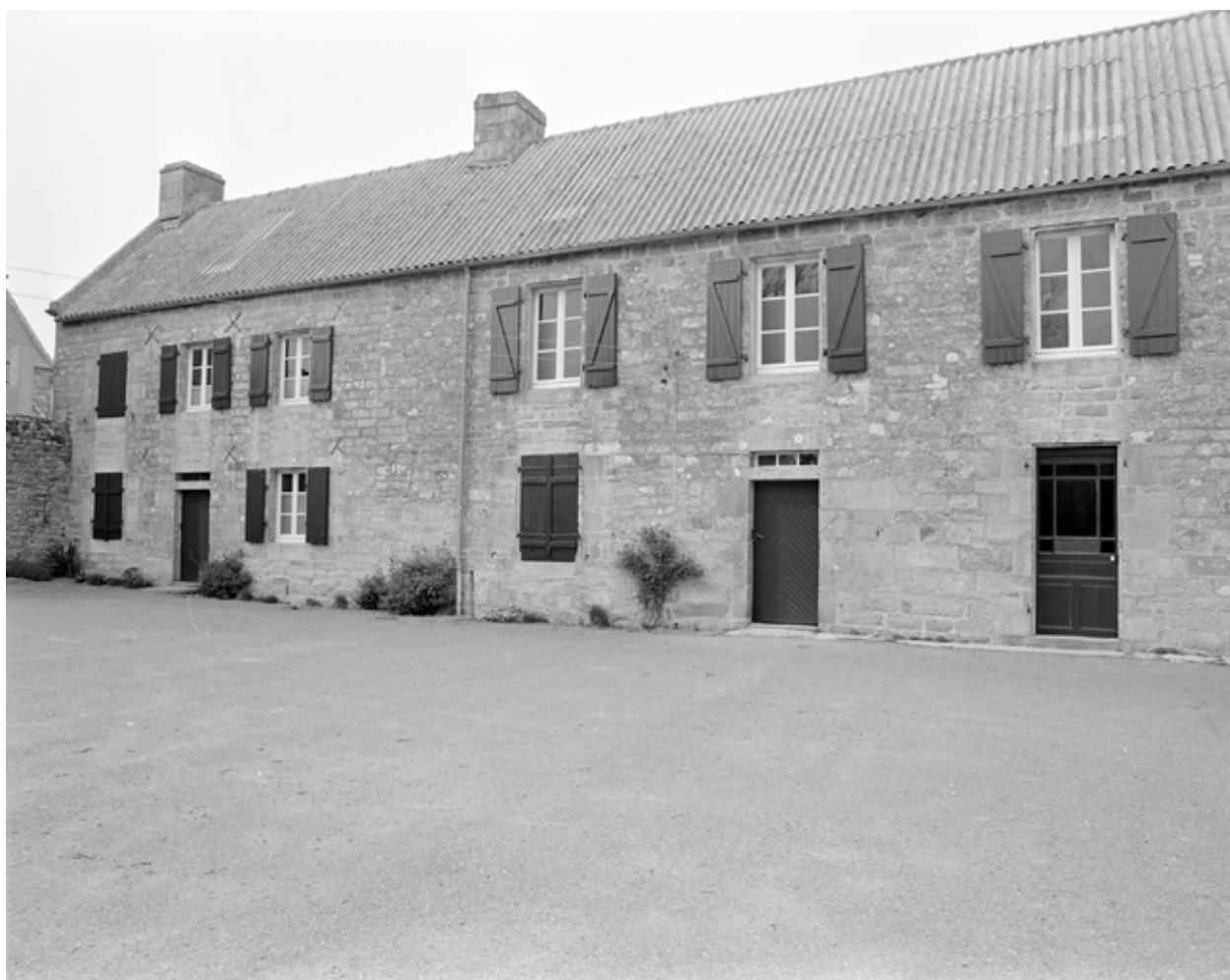
Elévation antérieure de l'alignement principal. (1977)
