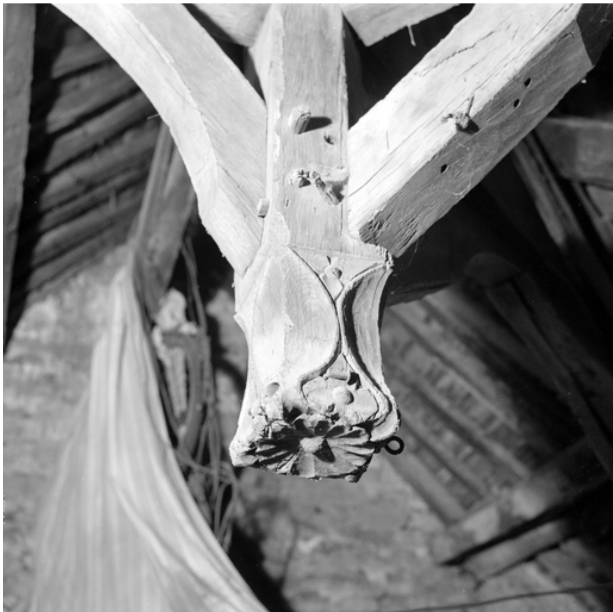
Charpente, extrémité sculptée du poinçon.
