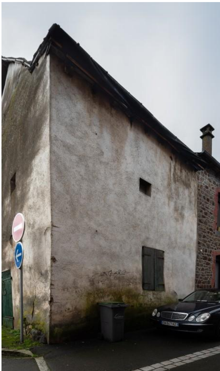
Façade arrière de l'édifice, entièrement enduite.
