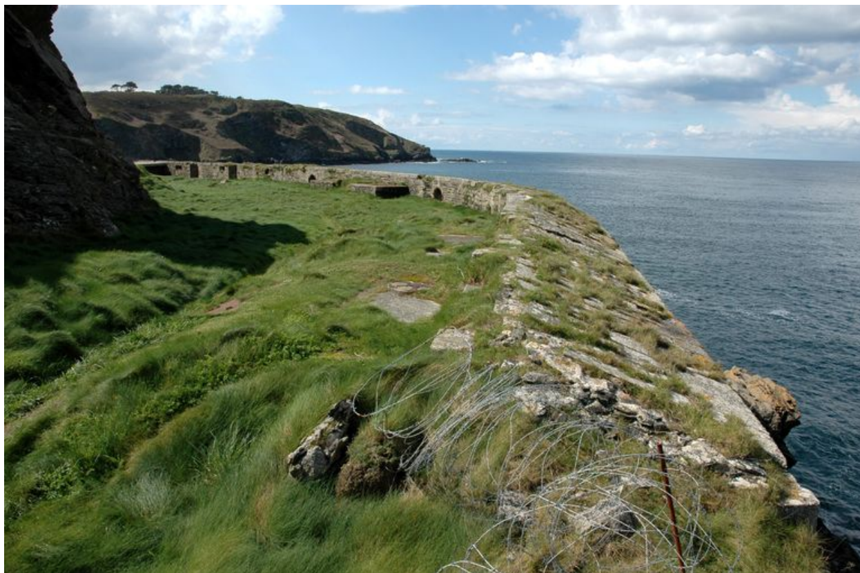
Vue de la batterie de Cornouaille : parapet. En arrière-plan : l'entrée du goulet de Brest
